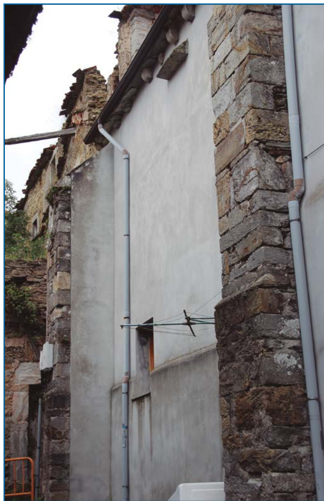
Contrafuertes de la fachada
