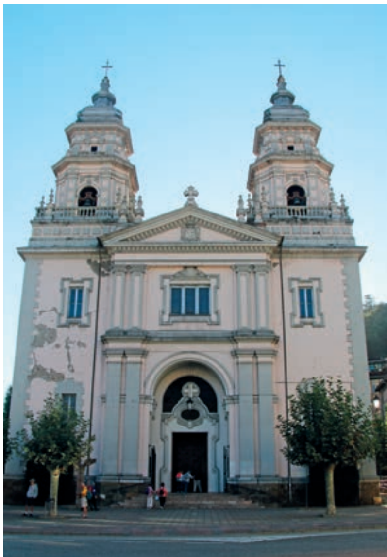
Iglesia de San Juan Bautista de Mieres del Camino
